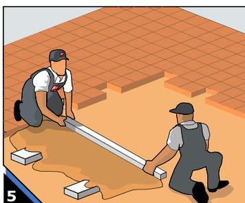
Sobre la base o sub base, se extiende la capa de arena con espesor de 2 a 3 cm que recibirá el Euroadoquín. Nunca debe usarse para cubrir imperfecciones de la capa anterior.
